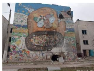
破壊された壁画
